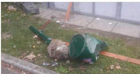
Betonfundament aus dem Boden gerissen.
